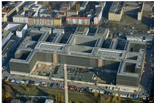
Abb. 35: Luftaufnahme der BND-Zentrale, Berlin, 14.11.2012.
